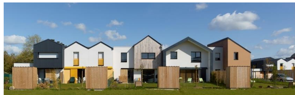
Opération groupée « Vert Buisson » à Bruz (35)
