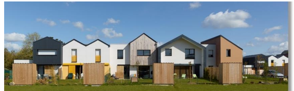
Opération groupée « Vert Buisson » à Bruz (35)
